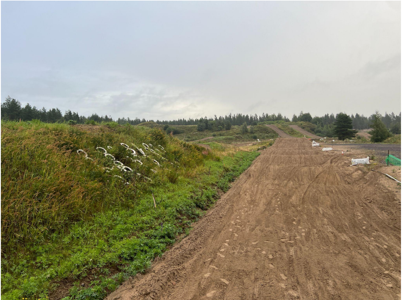
Kastelulaitteissa joustavat varret ja ne on mahdollisuuksien mukaan suojattu villapaaleilla
