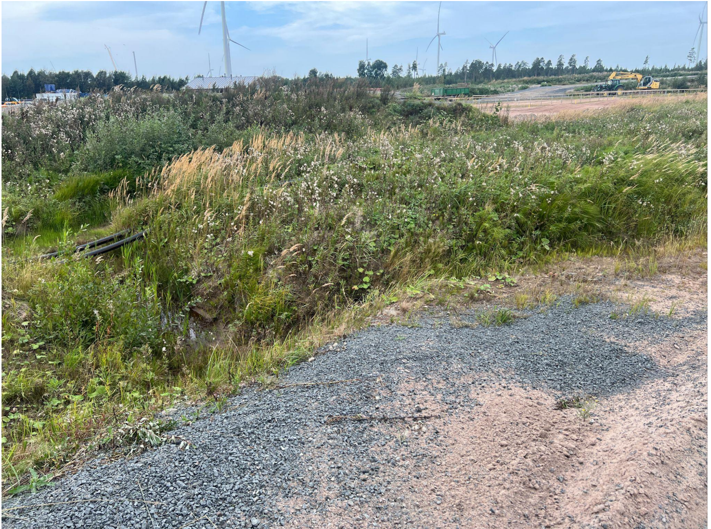
Radan läheisyydessä olevien ojien reunoja loivennetaan ja penkat tasataan
