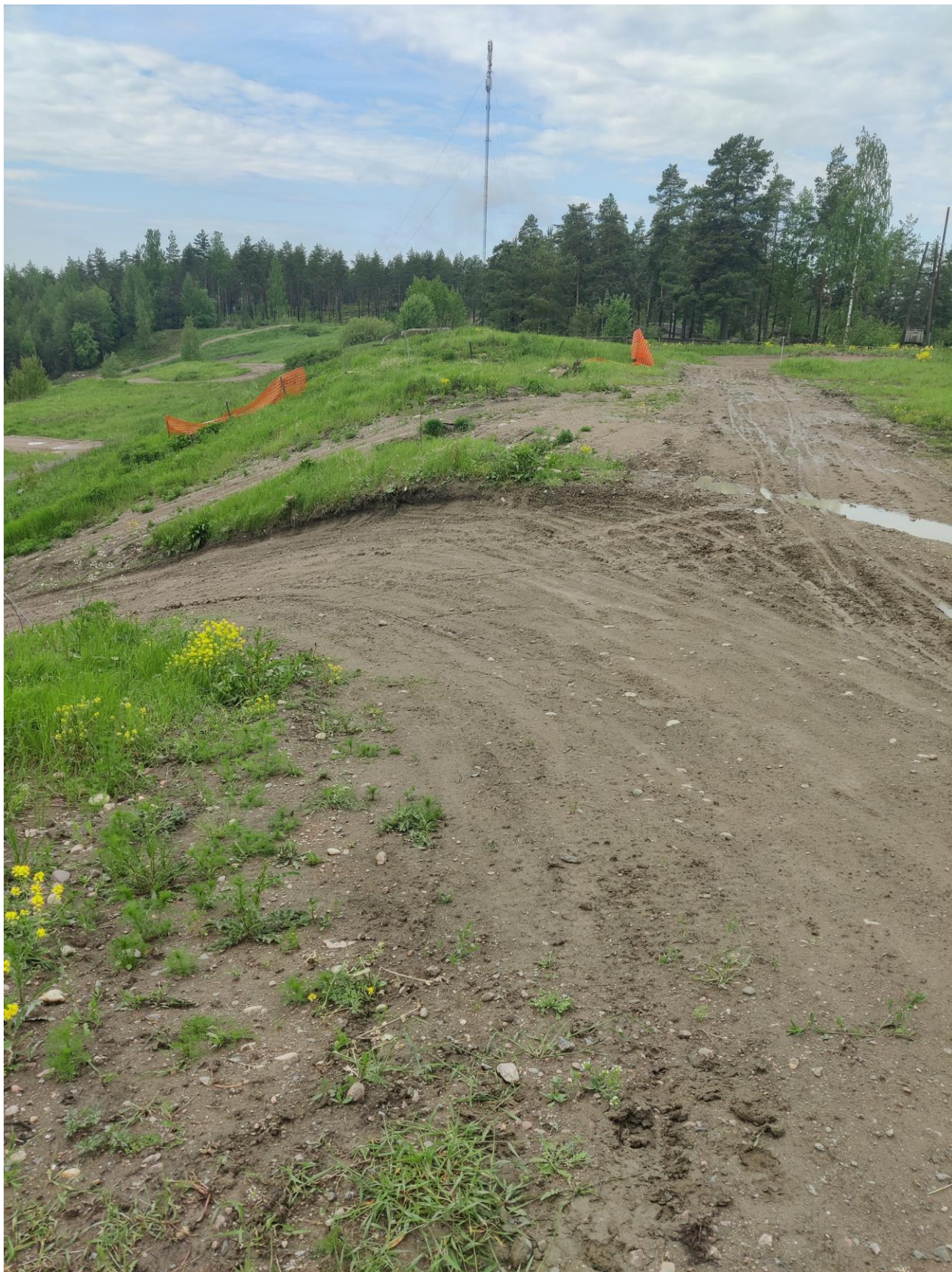
Kuva 1 Korjattava aita ratatuomaripiste 7 jälkeen
